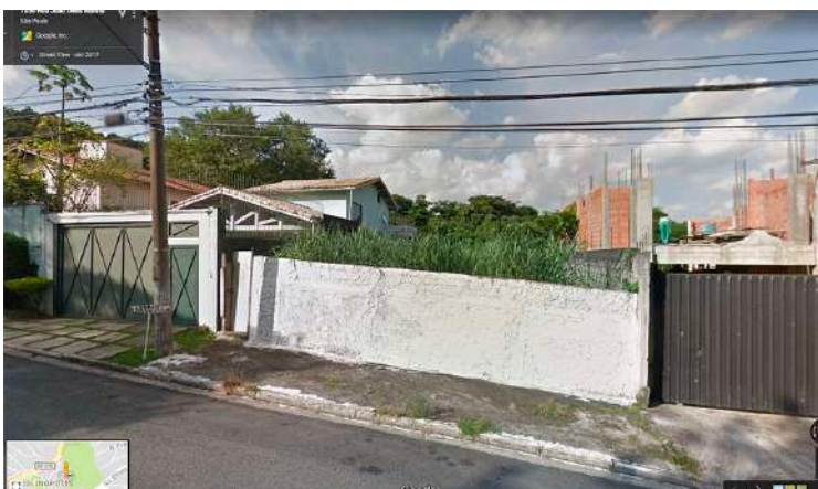
Frente do terreno baldio localizado na rua João Della Manna, ao lado do nº 1082.
