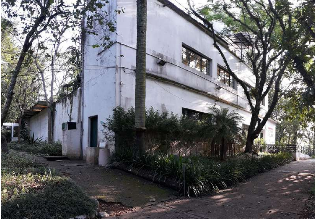
Vista geral prédio DGD/CECCO.
