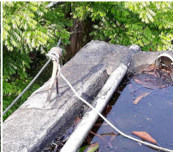
Vista aérea do telhado do prédio com a torre do para-raio e detalhe do aterramento rompido.
