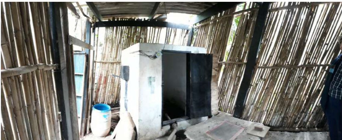
VISTA GERAL DA PARTE INTERNA DA CASA DE BOMBA.
