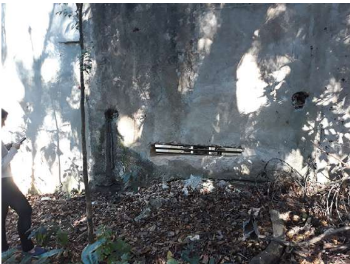
ABERTURA IRREGULAR VOLTADA PARA O PARQUE, COM CANO EXALANDO FORTE ODOR FÉTIDO.
