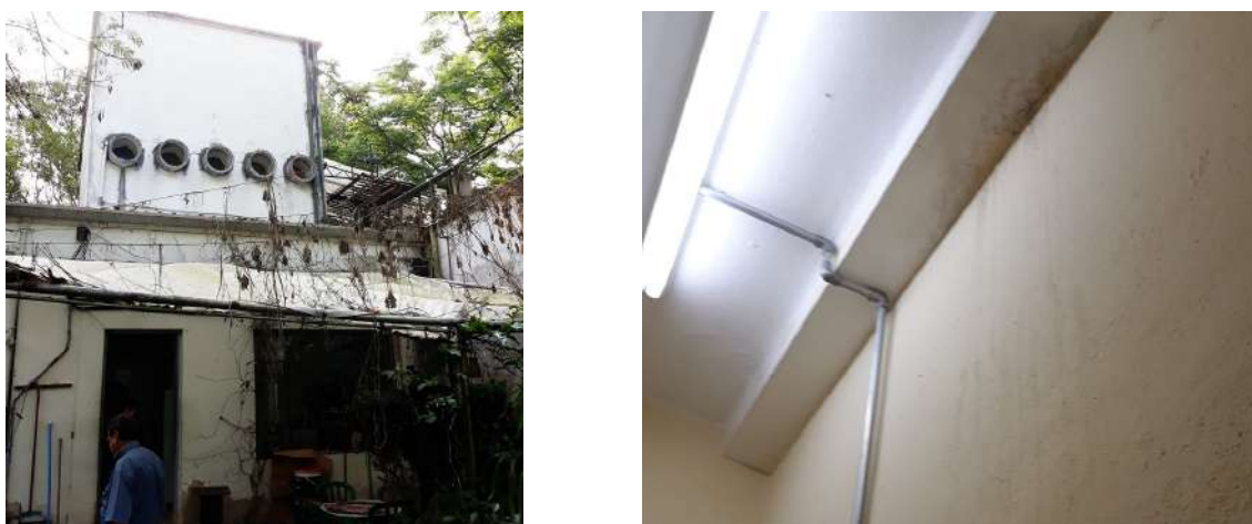
Vista da área superior do prédio e respectivas infiltrações na parte interna do prédio.
