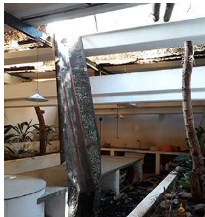
Calhas entupidas e imagem do desabamento das telhas no dia 02/10/18.
