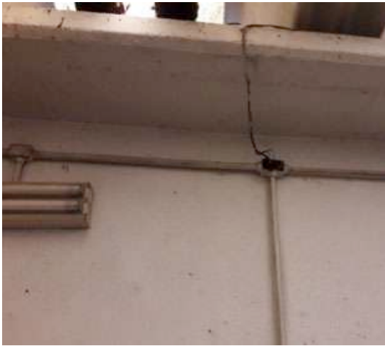
Prédio DGD: fiação e conduítes expostos. Direita: ponto de infiltração e de risco de curto circuito.
