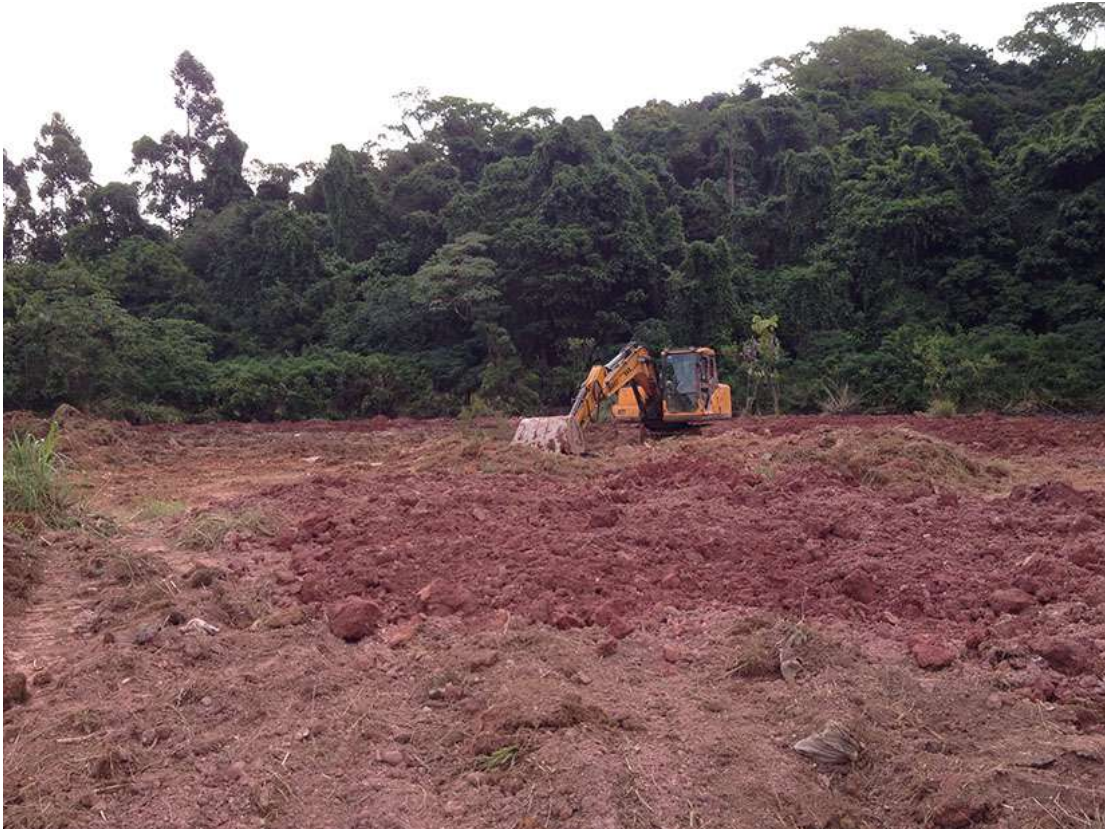
DESMATAMENTO E MOVIMENTAÇÃO DE TERRA PROMOVIDO PELO CARREFOUR EM 2015.
